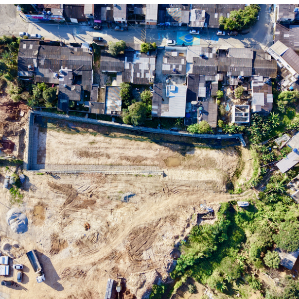
Obra protege moradias contra deslizamentos e leva mais segurança para as famílias
