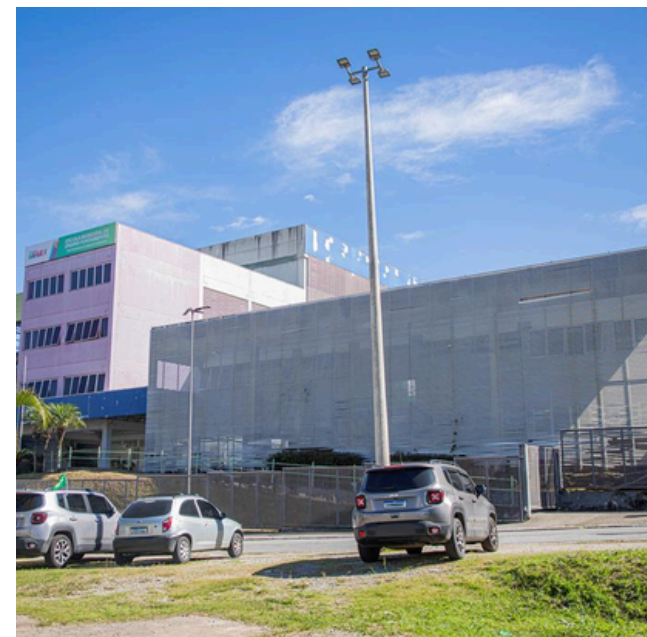
A obra inclui melhorias na estrutura, instalações, cobertura, pisos e pintura
